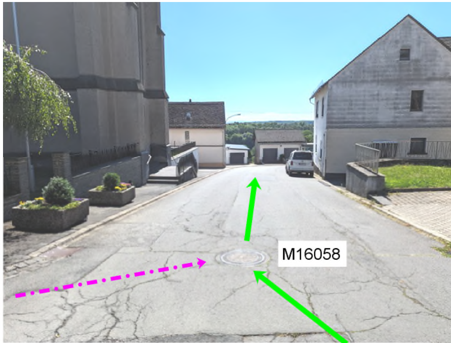
Foto oben: Schacht M16058 (Endschacht Sanierungsabschnitt 1, Startschacht Sanierungsabschnitt 2) MW-Haltung M16053 (von links) Zu renovierende MW-Haltungen M16060 (vorne) und M16058 (hinten)
